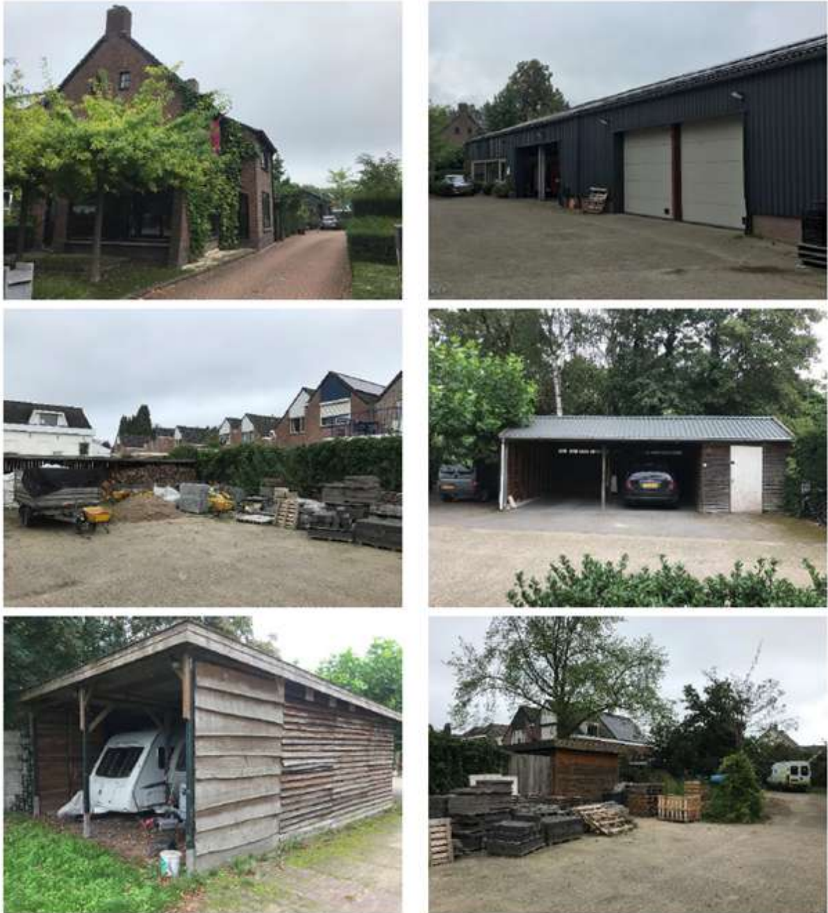
Figuur 2.1: Huidige situatie. De huidige woning (linksboven) blijft behouden. De overige opstallen van het voormalige hoveniersbedrijf worden gesloopt
