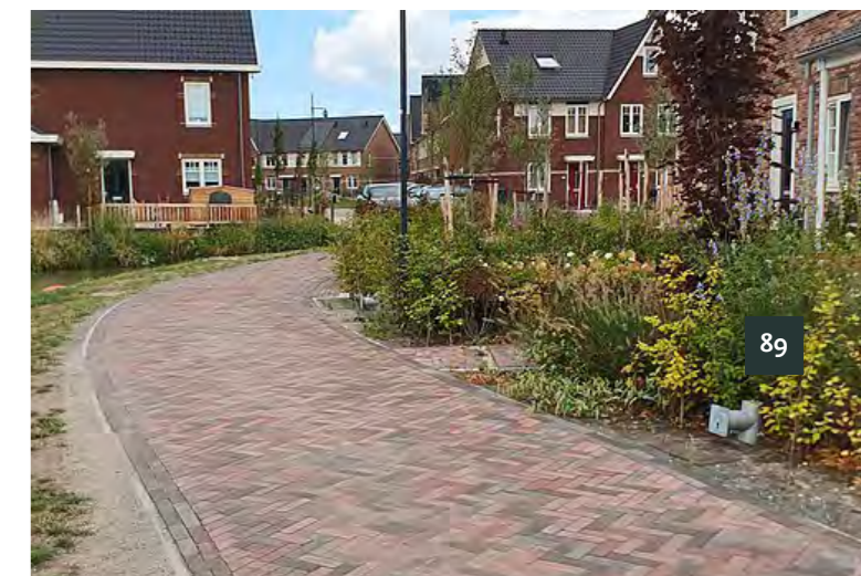
Afkoppelen van regenwater samen met klimaatbestendige beplanting
