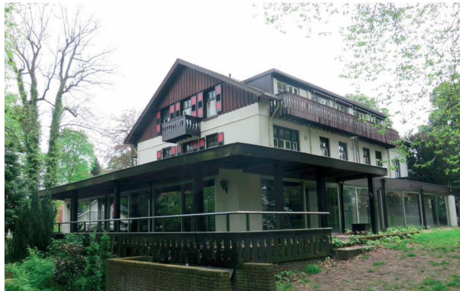
2 | Het bestaande beeld vóór sloop van het gebouw
